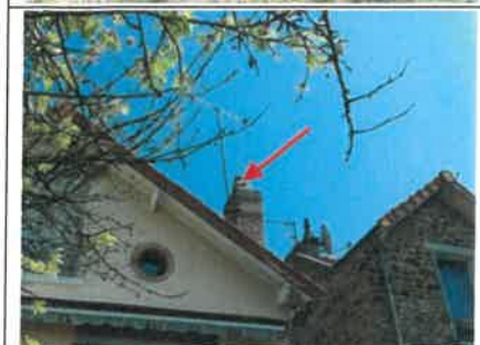
Photo n° PhA002 Localisation : Extérieur - Toiture Ouvrage : 6 - Conduits et accessoires intérieurs - Conduits de fluides (air, eau, vapeur, fumée, échappement, autres fluides) Partie d'ouvrage : Conduit en fibres-ciment Description : Conduit en fibres-ciment Localisation sur croquis : M002
