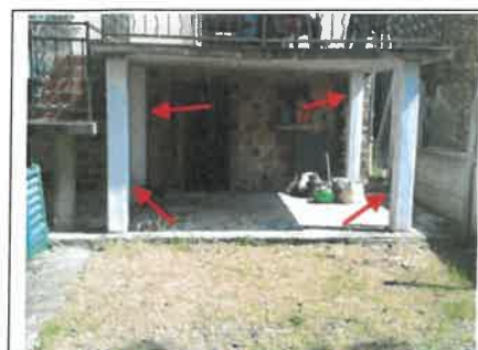
Photo n° PhA001 Localisation : Extérieur - sous terrasse Ouvrage : 6 - Conduits et accessoires intérieurs - Conduits de fluides (air, eau, vapeur, fumée, échappement, autres fluides) Partie d'ouvrage : Conduit en fibres-ciment Description : Conduit en fibres-ciment Localisation sur croquis : M001
