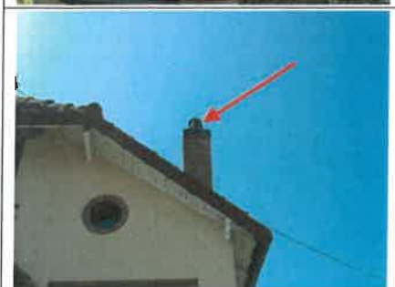
Photo n° PhA003 Localisation : Extérieur - Toiture Ouvrage : 6 - Conduits et accessoires intérieurs - Conduits de fluides (air, eau, vapeur, fumée, échappement, autres fluides) Partie d'ouvrage : Conduit en fibres-ciment Description : Conduit en fibres-ciment Localisation sur croquis : M003
