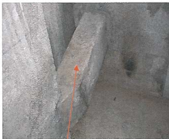
Conduit amiante fibrociment dans la circulation de caves gauche bâtiment 85 vers cave n°9
