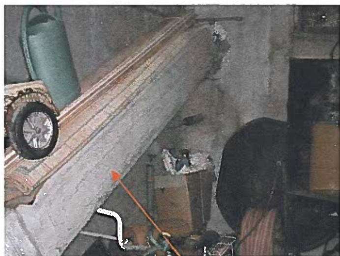
Conduit amiante fibrociment dans local vélos bâtiment 83
