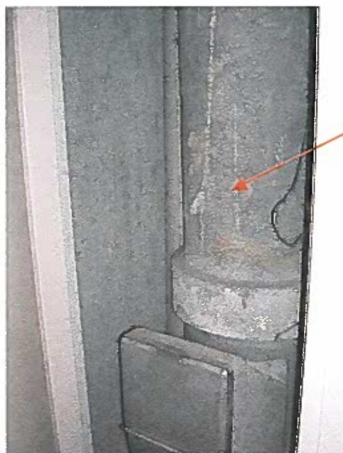
Conduit + mitron amiante fibrociment sur les terrasses
